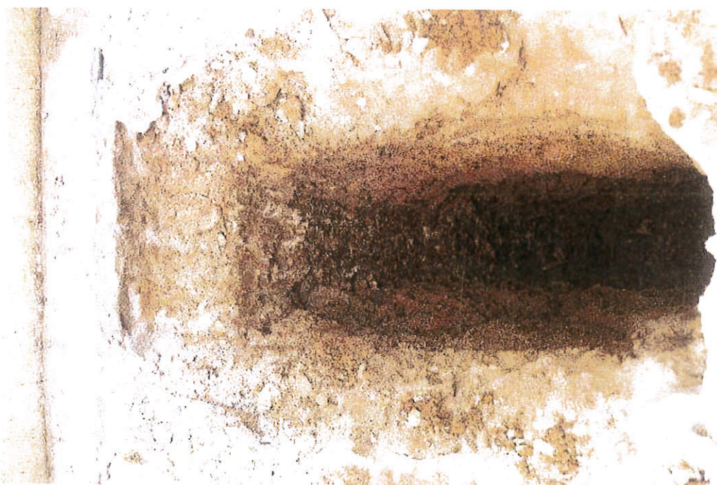
Σχήμα Χ.17α: Ερευνητικό φρέαρ Φ4. Φαίνεται η διεύρυνση της λίθινης θεμελιολωρίδας κατά 65cm, σε σχέση με το πάχος του επίσης λίθινου τοίχου του ναού.
