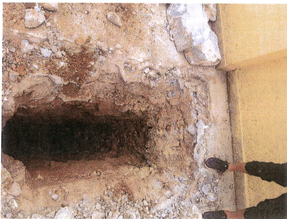
Σχήμα Χ.18α: Ερευνητικό φρέαρ Φ5. Φαίνεται η διεύρυνση της λίθινης θεμελιολωρίδας κατά 65cm, σε σχέση με το πάχος του επίσης λίθινου τοίχου του ναού.
