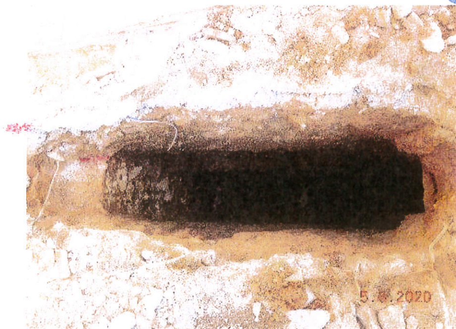
Σχήμα Χ.15α: Ερευνητικό φρέαρ Φ2. Φαίνεται η διεύρυνση της λίθινης θεμελιολωρίδας κατά 60cm, σε σχέση με το πάχος του επίσης λίθινου τοίχου του ναού.
