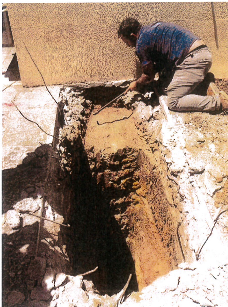
Σχήμα Χ.14α: Ερευνητικό φρέαρ Φ1. Φαίνεται η διεύρυνση της λίθινης θεμελιοωρίδας κατά 60cm, σε σχέση με το πάχος του επίσης λίθινου τοίχου του ναού.
