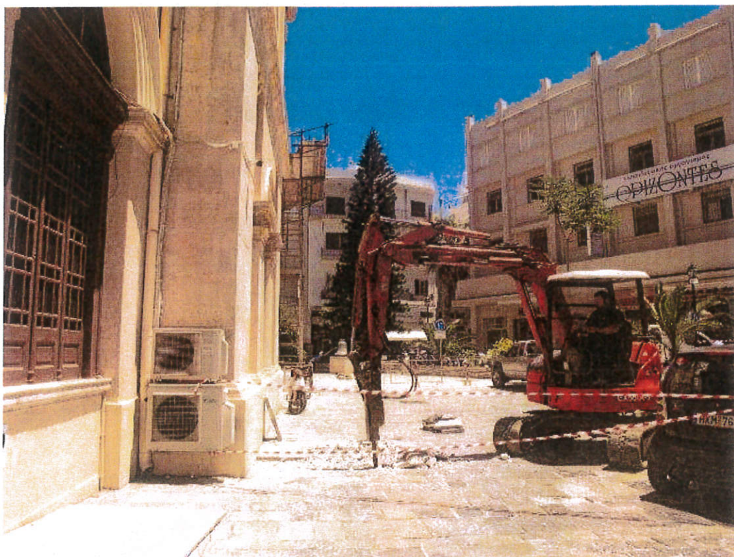
Σχήμα Χ.12: Άποψη της τσάπας που χρησιμοποιήθηκε για την διάνοιξη των ερευνητικών φρεάτων (τομών).
