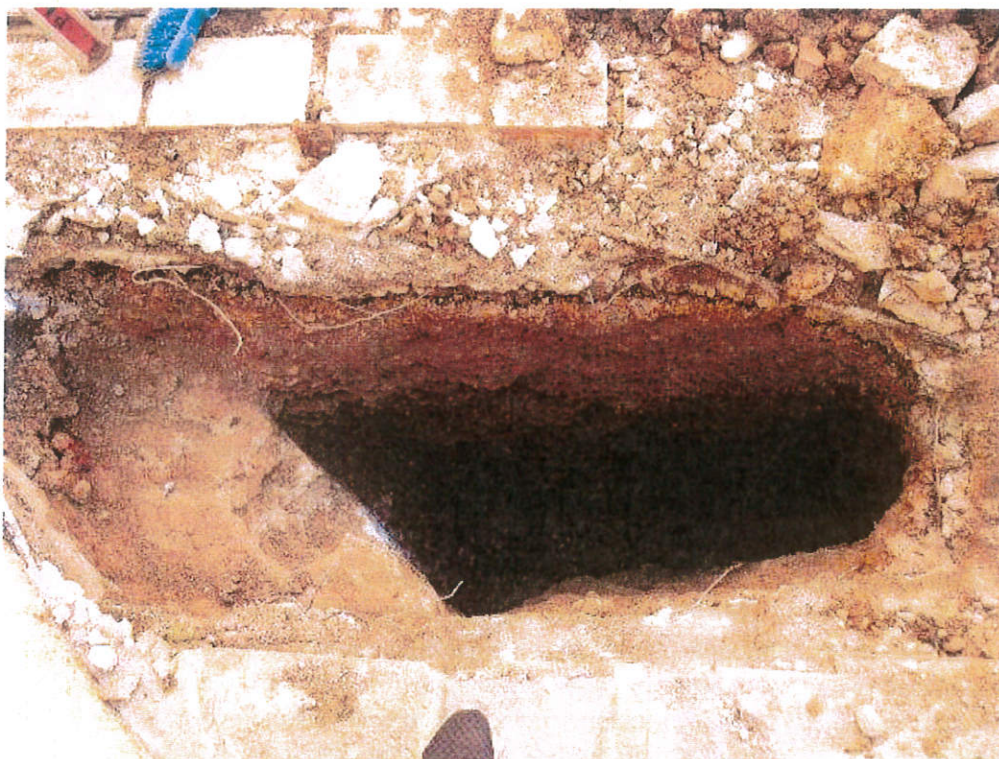
Σχήμα Χ.16α: Ερευνητικό φρέαρ Φ3. Φαίνεται η διεύρυνση της λίθινης θεμελιολωρίδας κατά 60cm, σε σχέση με το πάχος του επίσης λίθινου τοίχου του ναού.
