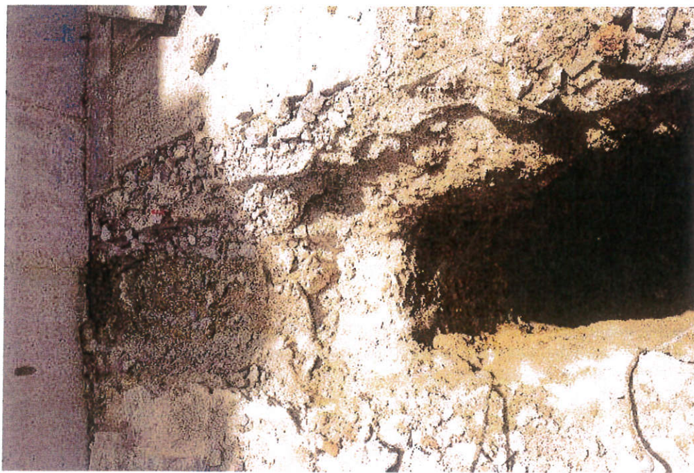
Σχήμα Χ.19α: Ερευνητικό φρέαρ Φ7. Φαίνεται η διεύρυνση της λίθινης θεμελιολωρίδας κατά 100cm, σε σχέση με το πάχος του επίσης λίθινου τοίχου του ναού.
